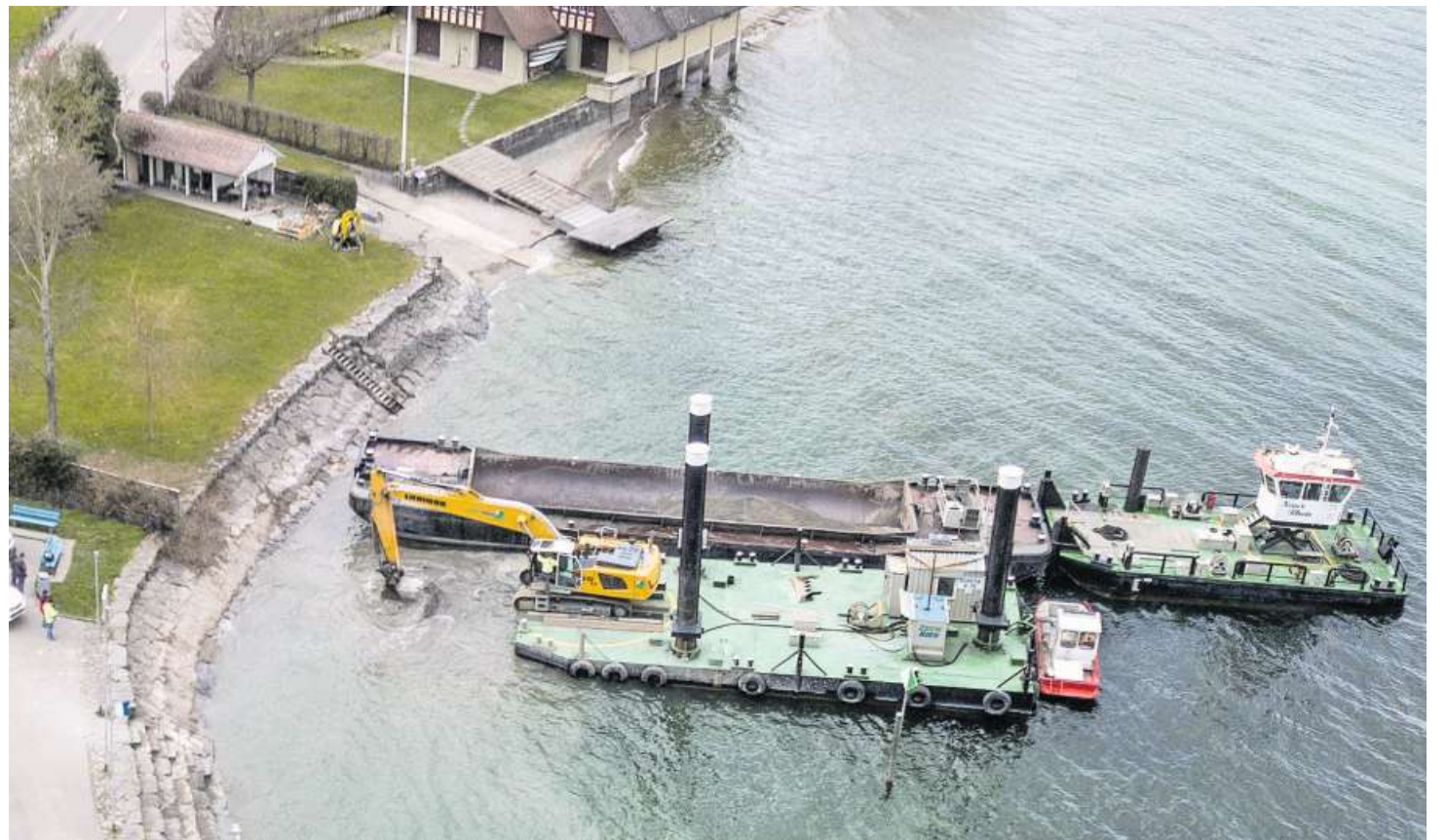
Aus Sand und Kies, der an der Küste Goldachs den Schiffsverkehr behindert, baut der Kanton eine Kinderstube für Fische.
